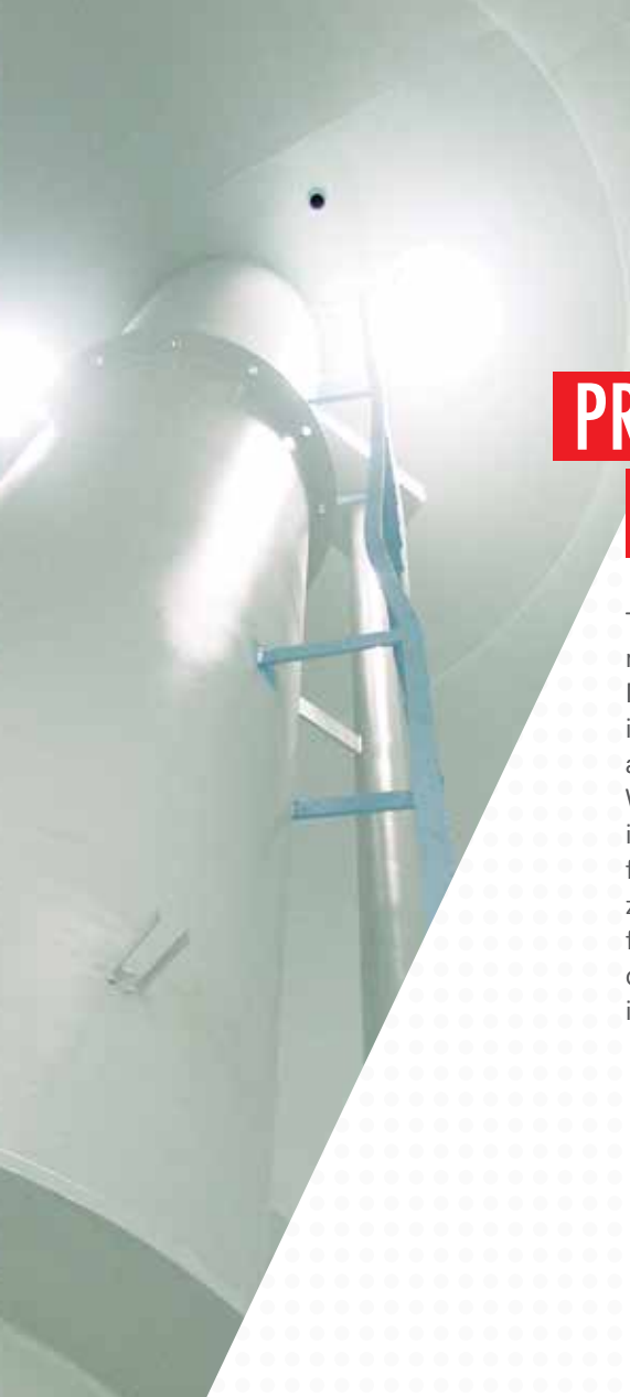
above: Tank Interior Rosemont, IL
